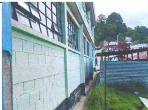
Foto 4: Pintura en muro exterior en edificio escolar
